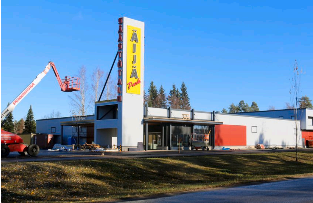
Länsiväylän varrelle Pieksämäelle on kesän aikana noussut Äijäparkin ja Säästötalon uusi liikerakennus.
